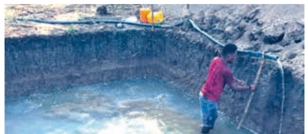
La construction du bassin destiné à la pisciculture.
