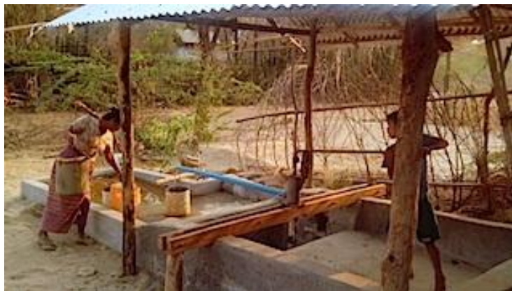
Vue d'ensemble du puits avec forage et pompe à main
